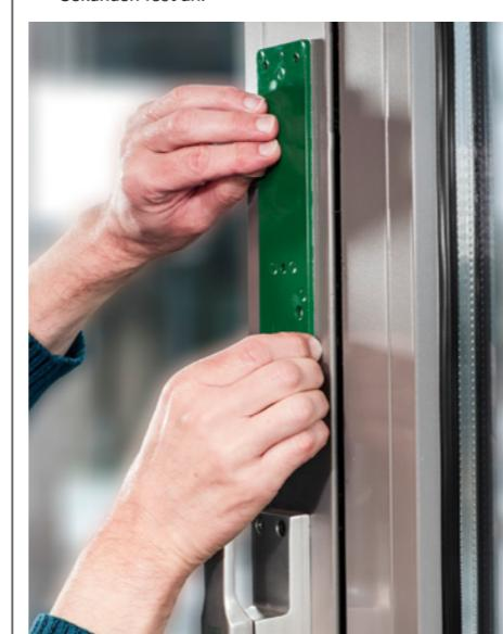
Es ist unbedingt darauf zu achten, daß der mechanische Auslöseweg des Treibriegels bis zu seinem Endanschlag gewährleistet ist. Der GfS Flügelwächter® und seine Montagehilfen müssen nach Auslösung den Betätigungs weg des Treibriegels komplett freigeben.
